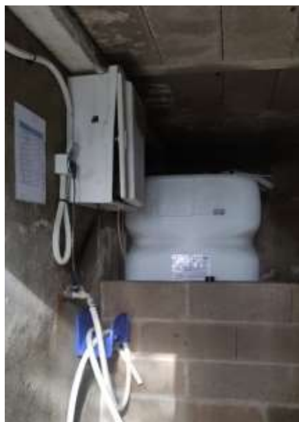
Figura 35. Cloración depósito Samieira
