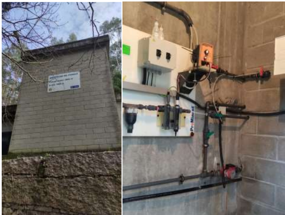
Figura 30. Exterior y cloración depósito Pomar
