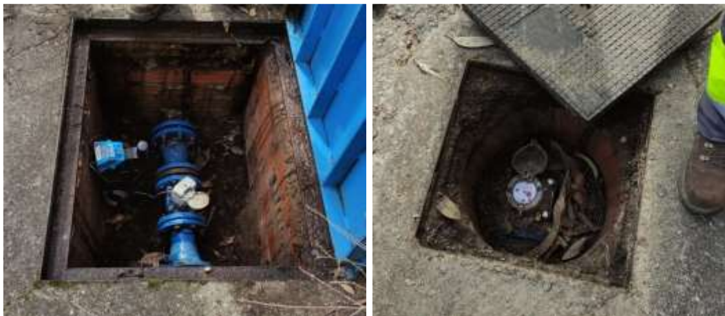
Figura 31. Contadores salida depósito Pomar
