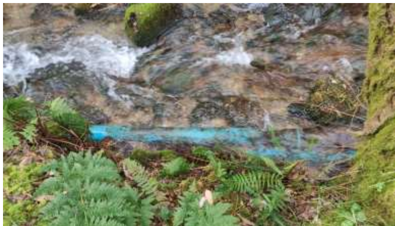
Figura 5. Tubería de PVC que conduce el agua captada hasta el desarenador
