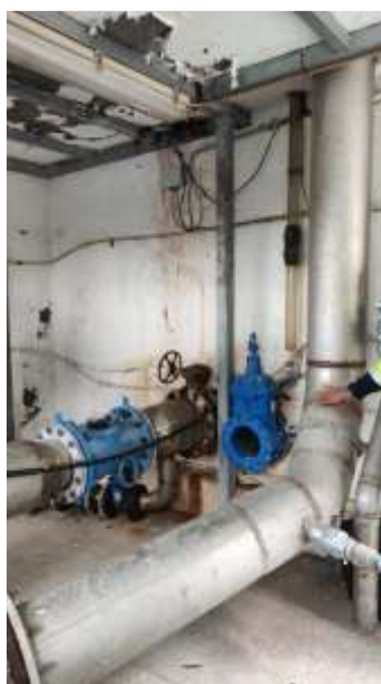
Figura 20. Tuberías de impulsión depósito Albar
