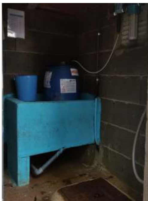
Figura 25. Cloración depósito Salgueirños
