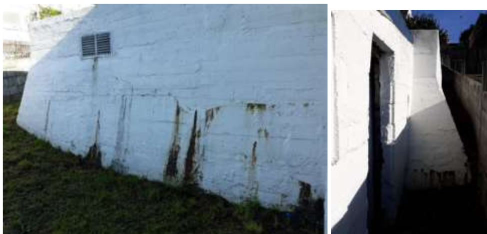
Figura 15. Detalle filtraciones depósito A Caeira
