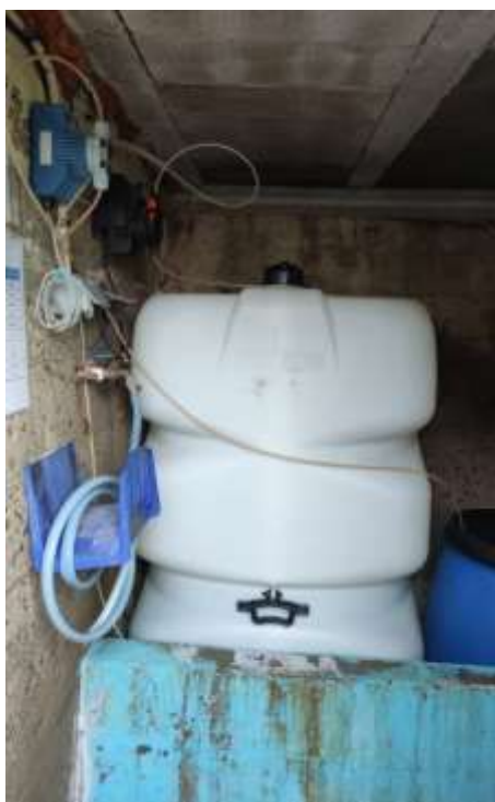
Figura 11. Cloración depósito Boavista
