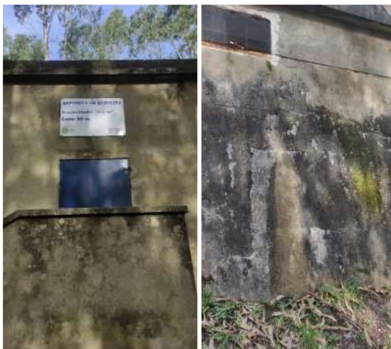
Figura 33. Señalización y filtraciones depósito Samieira
