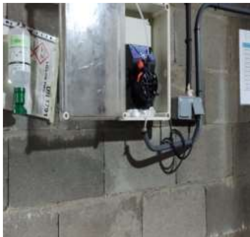
Figura 14. Bomba dosificadora de cloro A Caeira
